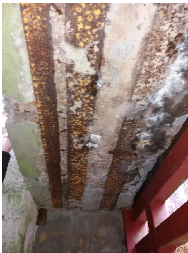
zdj. 6 – Nadproże w miejscu montażu kraty. [fot. Z. Hryniuk]
