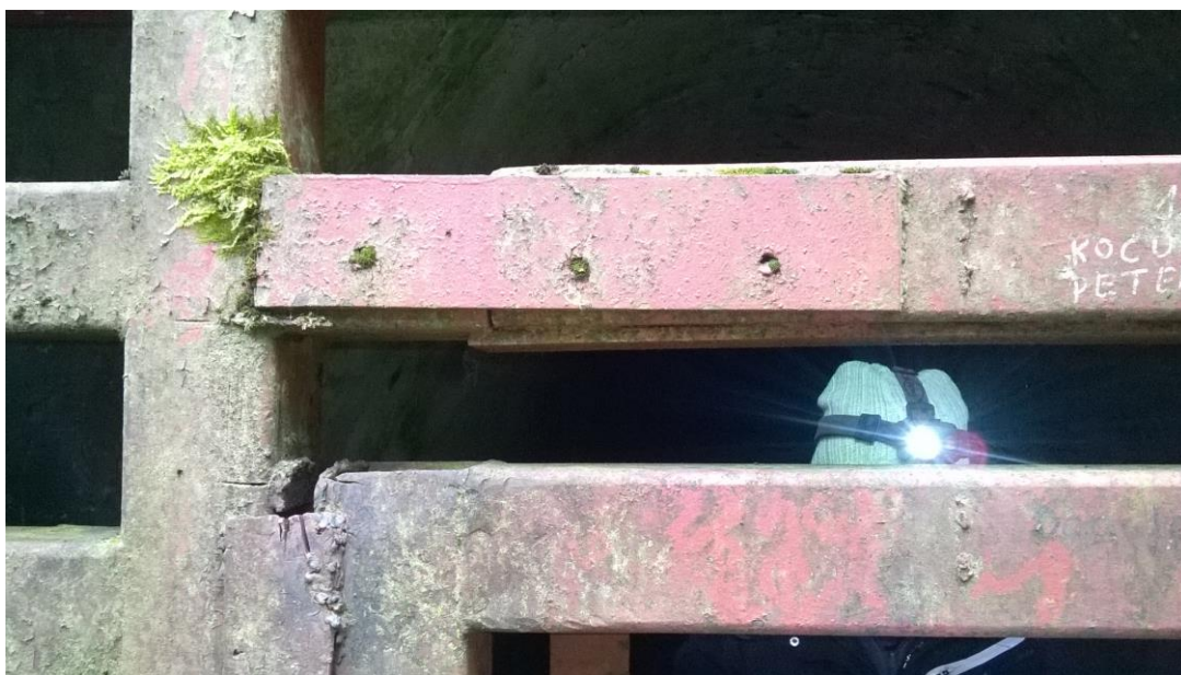
zdj. 5 – Prowizoryczne naprawy uszkodzeń kraty. [fot. Z. Hryniuk]
