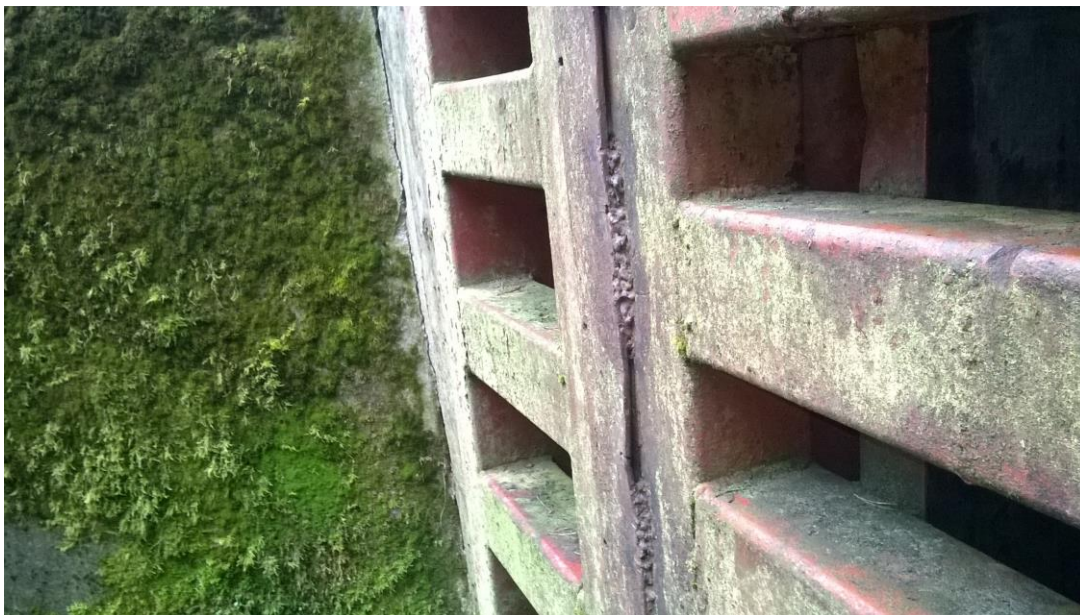
zdj. 4 – Krata od zewnątrz – widoczne spawy zamykające wejście do obiektu. [fot. Z. Hryniuk]
